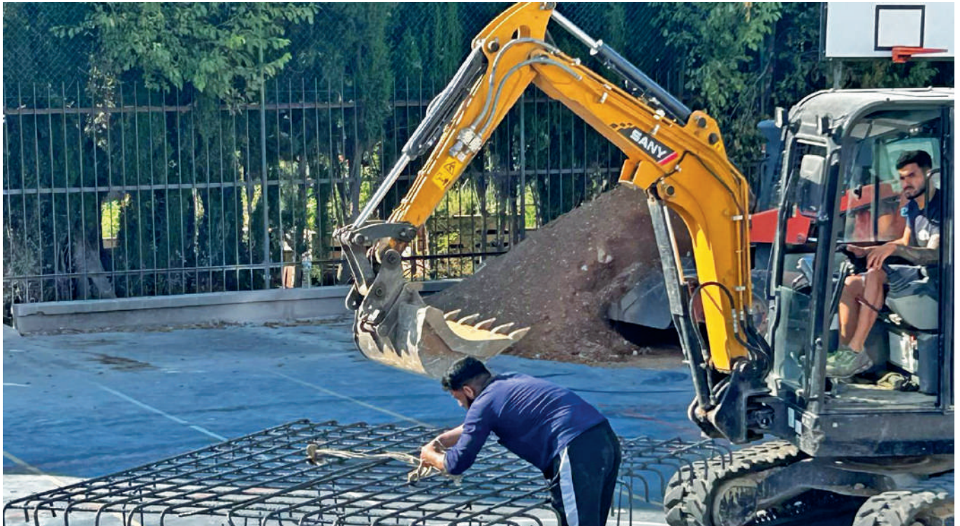
Obres d'instal·lació, aquest estiu, de la nova pèrgola de l'escola Tiziana, que protegirà la pista del sol els dies de calor. AJ TIANA
